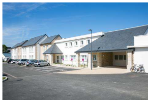
Villa Amélie – St Rogatien (17) – EHPAD – Construction neuve – réception en février
