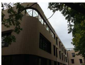
MSE – Epinay sur Seine (93) – Clinique psychiatrique – Extension et réhabilitation de l'établissement existant – Réception programmée en Septembre
