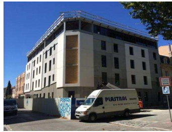
Les Mimosas – Narbonne (11) – EHPAD – Extension et réhabilitation de la Résidence existante – Réception de l'extension en Décembre
