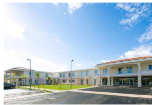
Villa Océane – Belz (56) – EHPAD – Construction neuve - Réception en Mars
