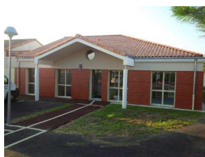
Les Jardins d'Olonne – Olonne sur Mer (85) – EHPAD – Création d'un accueil de jour – Réception programmée en Septembre
