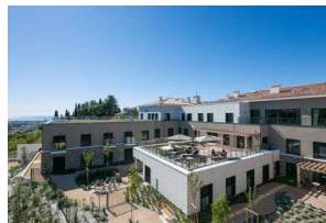
Villa des Collettes – Cagnes sur Mer (06) – EHPAD – Construction neuve – Réception en Juillet
